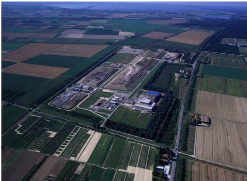
Fig. 1 – Discarica HERA Spa (ex-AREA S.p.A).
