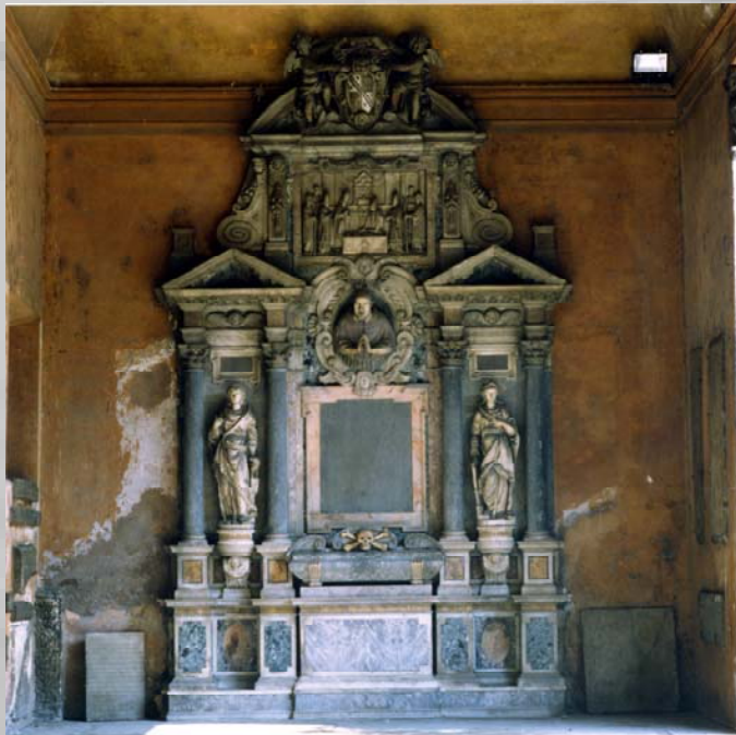
Monumento Sfondrato prima del restauro
