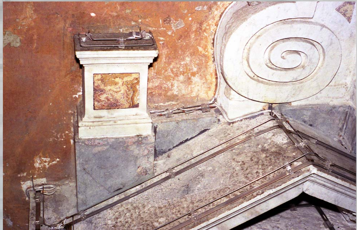
Roma, Santa Cecilia – Monumento Sfondrato Durante l'installazione dell'impianto antipicceione
