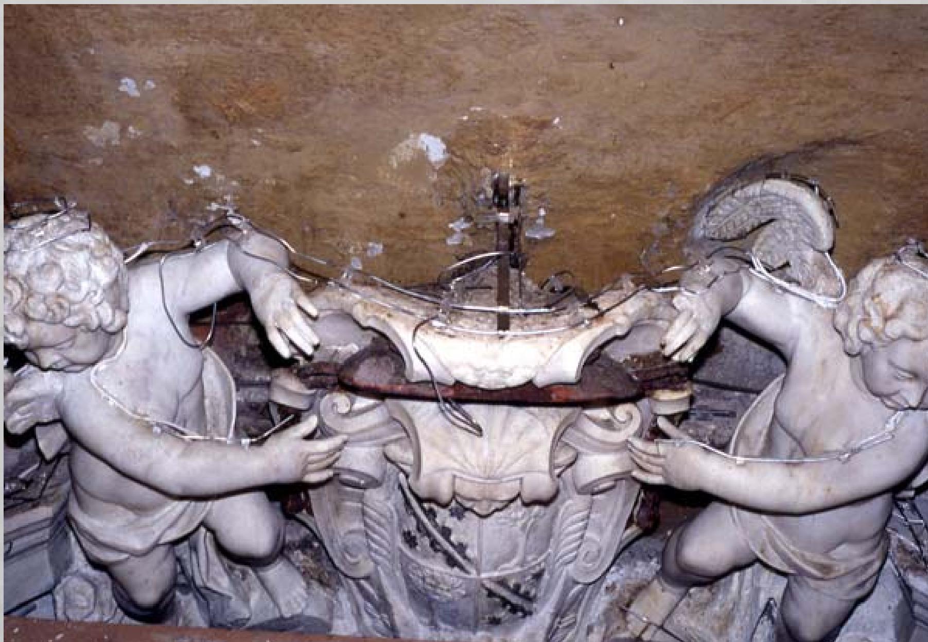
Roma, Santa Cecilia – Monumento Sfondrato Durante l'installazione dell'impianto antipiczione
